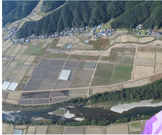
土木工事 ② ほ場整備工事
