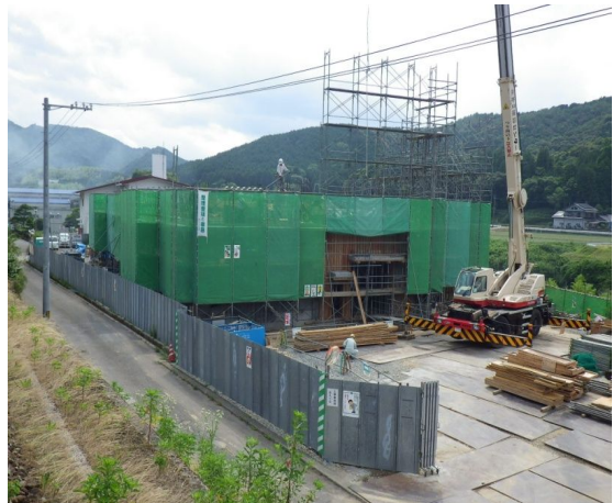
建築工事 ② 汚泥処理センター
