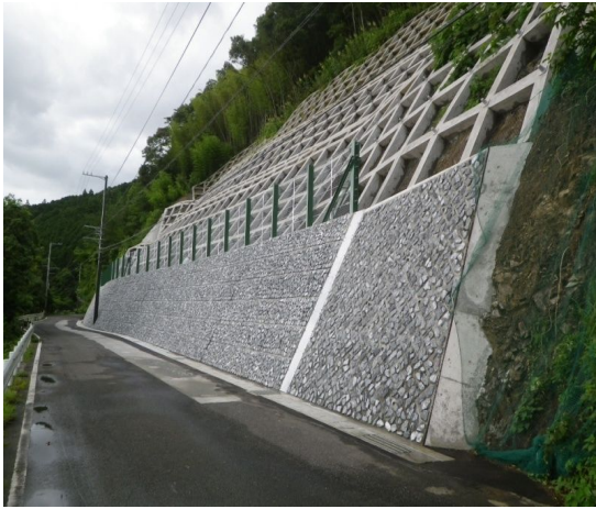
土木工事 ① 道路改良工事
