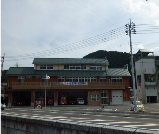
建築工事 ① 消防庁舎
